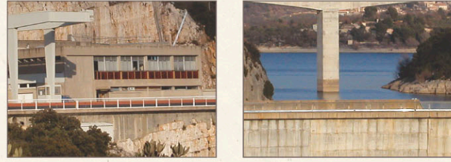
Barrage de Sainte Croix. Alimenté par de multiples sources, le barrage permet l'alimentation en eau et la production d'électricité.
